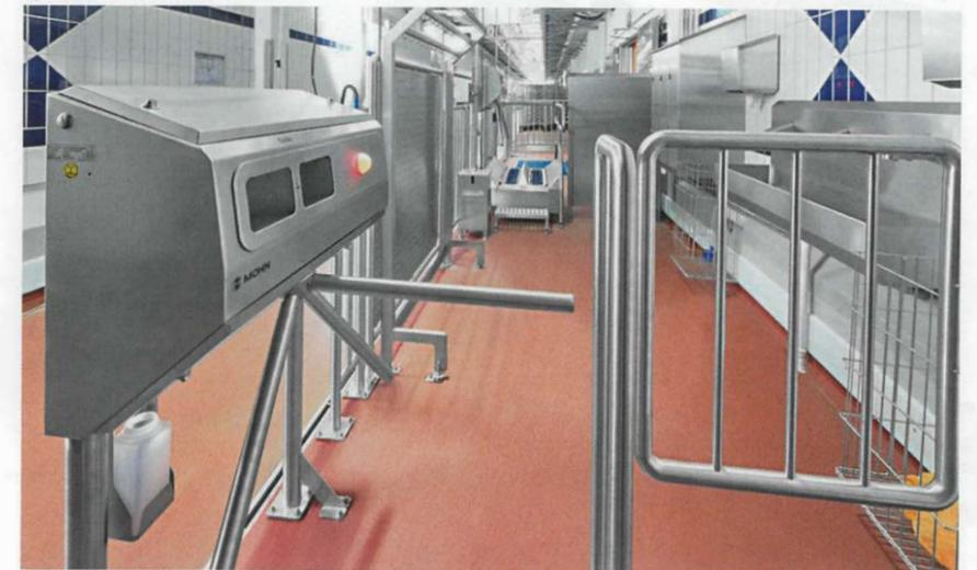
Hauptgang der Personal-Hygieneschleuse, links im Vordergrund der Seifenautomat mit überlastungssicherer Sensortechnik, rechts die sensorgesteuerte Mehrplatz-Waschrinne und im Hintergrund überlastungssichere Zweihand-Desinfektion sowie Sohlenreinigung und Desinfektion.
