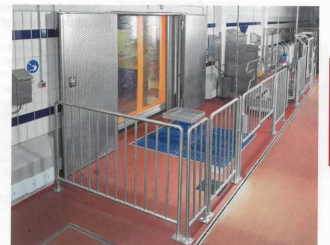
Die Magnetore sind fluchtwegtauglich und koppelbar mit der Brandmeldeanlage.
