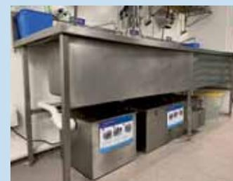
de, einfach zu handhaben ist und laut Hersteller aufgrund seiner Konstruktion mit acht Hydrozyklonen weltweit die höchste Fettrückgewinnungsrate bietet. Das durch das Gerät abgeschiedene Öl ist qualitativ so gut, dass es zu Biodiesel weiterverarbeitet werden kann und für Betriebe eine zusätzliche Einnahmequelle darstellt.
